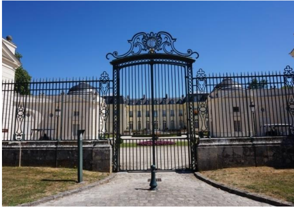
Accès depuis la RD42 et pavillons d'entrée
