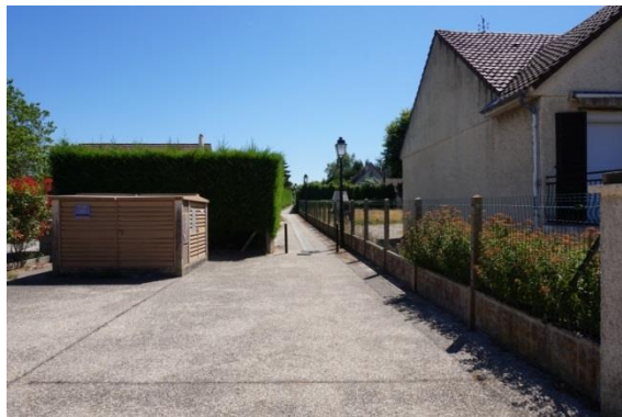
Réfection de la sente piétonne entre la rue de la Masse et la route du Moutier
