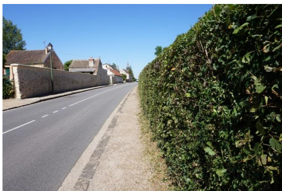
Mur en pierres à gauche et haie végétale à droite
