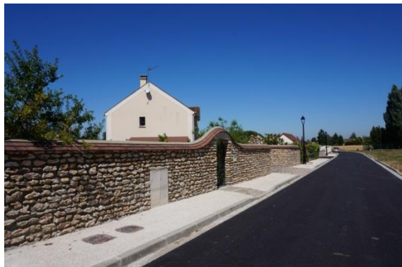
Réfection de la voirie, rue de la Tuilerie
